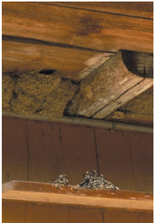
Fot. 120. Jak widać, zabezpieczenie w postaci deseczki skutecznie chroni elewację budynku (fot. K. Walasz).
