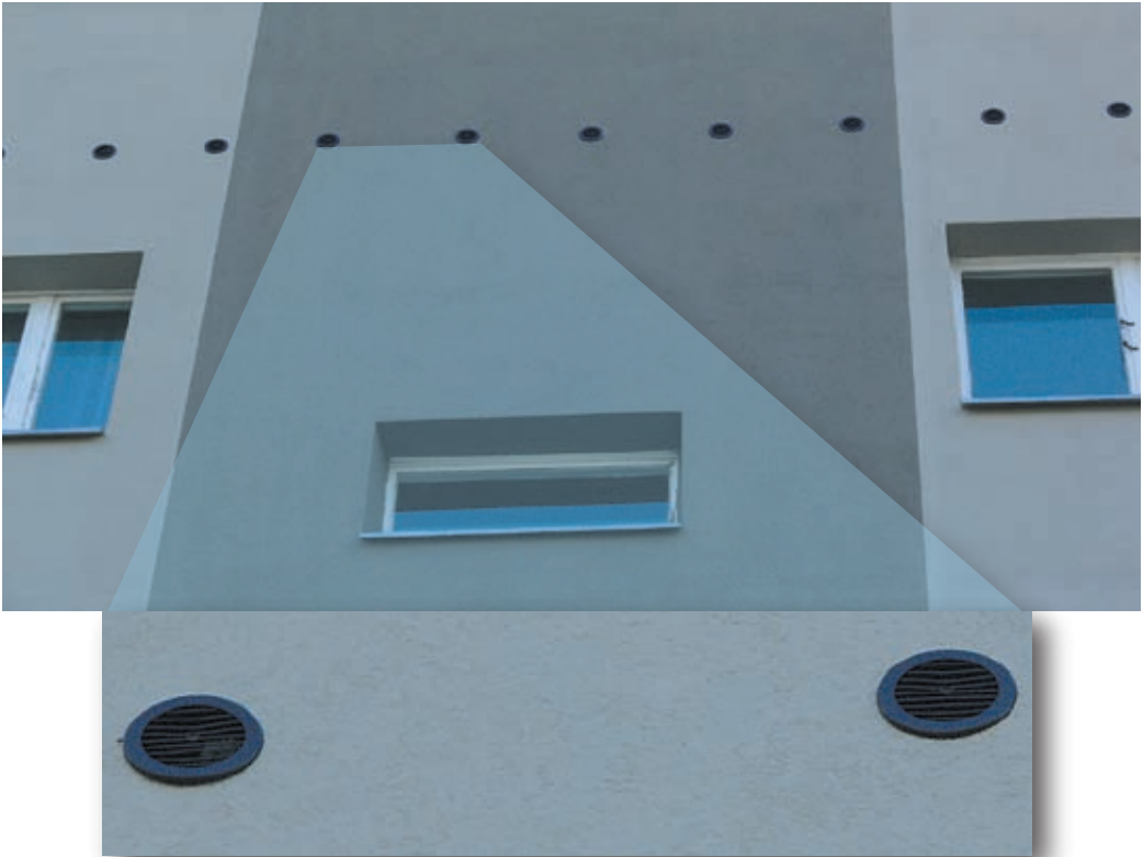
Fot. 47. Po ociepleniu budynku z wielkiej płyty otwory wentylacyjne są zamknięte kratą uniemożliwiającą dostęp ptakom (fot. K. Walasz).
