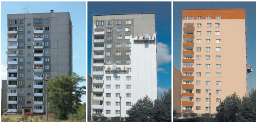
Fot. 41, 42, 43. Typowy blok mieszkalny – składany z prefabrykowanych wielkich płyt. Budynki takie stawiano od lat 70. do początku lat 90. ubiegłego wieku. Mają one olbrzymi udział w wielorodzinnym budownictwie mieszkaniowym w całym kraju. Ocieplanie budynków z wielkiej płyty likwiduje miejsca lęgowe dla jerzyków, kawek, wróbli i szpaków (fot. K. Walasz).
