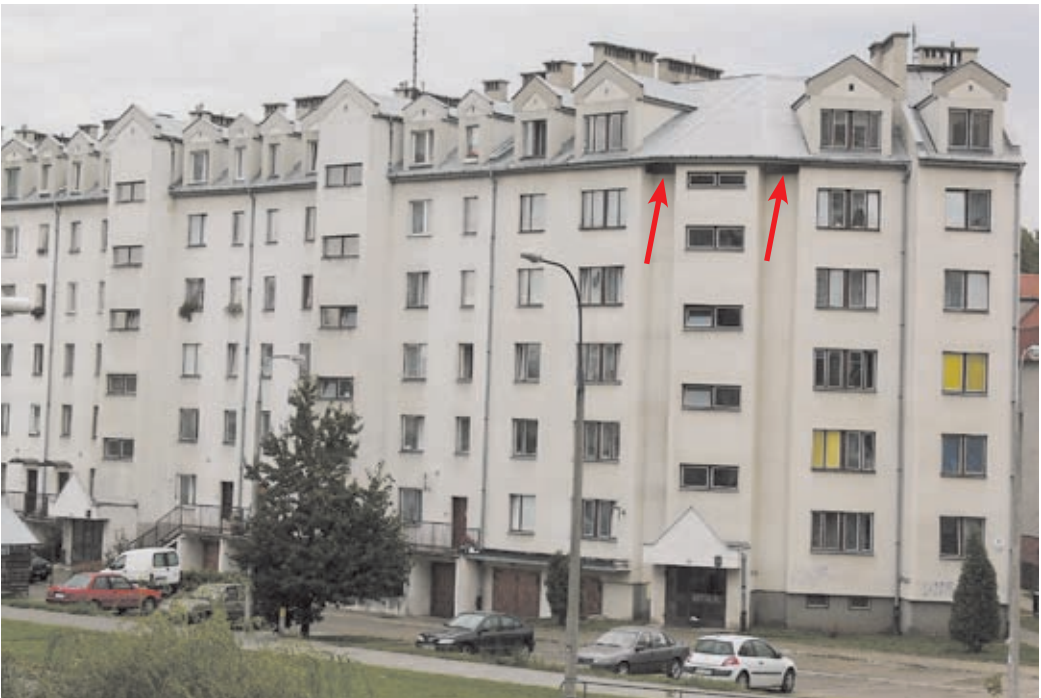
Fot. 124. Blok mieszkalny z końca lat 90. ubiegłego wieku. Pozostawione na poddaszu nisze stanowią miejsca noclegowe dla gołębi miejskich, a także miejsca lęgowe pustulek (fot. K. Walasz).
