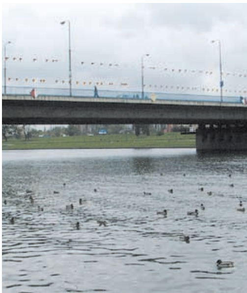
Fot. 115. By uniknąć kolizji ptaków na mostach w Krakowie, Zarząd Dróg i Komunikacji oznakował przewody tramwajowe (z obu stron mostów) pomarańczowymi proporczykami (fot. K. Walasz).
