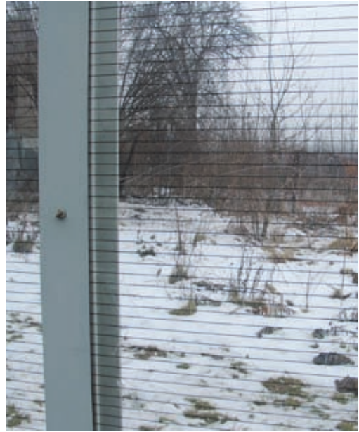
Fot. 118. Tutaj umieszczono dość gęsto wąskie paski poziome. Badania szwajcarskie wykazały, że najlepsze efekty przynosi umieszczenie pionowych pasków o szerokości co najmniej 2 cm i odległych od siebie 10 cm (fot. K. Walasz).
