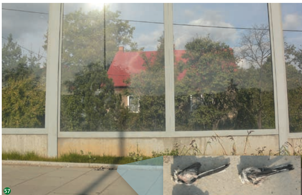
Fot. 57, 58. Ekran akustyczny zbudowany z szyb i umieszczony na tle zieleni jest śmiertelną pułapką dla ptaków. Na zdjęciu ekran z poprzedniego zdjęcia. Pod nim leżały trzy martwe raniuszki (fot. K. Walasz).
