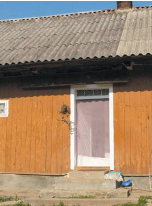
Fot. 119. Zabezpieczenie przed brudzeniem elewacji budynku przez jaskółki oknówki. Właściciel budynku umocował deseczkę na szerokość gniazda, która zabezpiecza elewację przed odchodami jaskółek (fot. K. Walasz).
